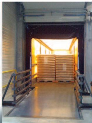
Le semi en cours de chargement semble bien positionné, pourtant le quai ne repose que de 2 cm. !!!
